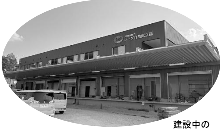
建設中の 草津センター
