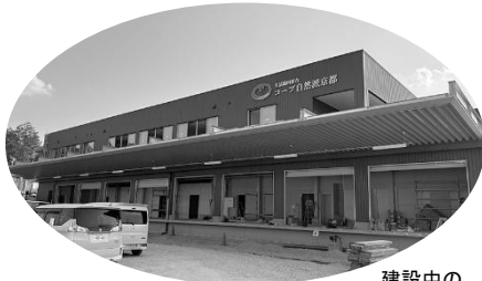
建設中の 草津センター
